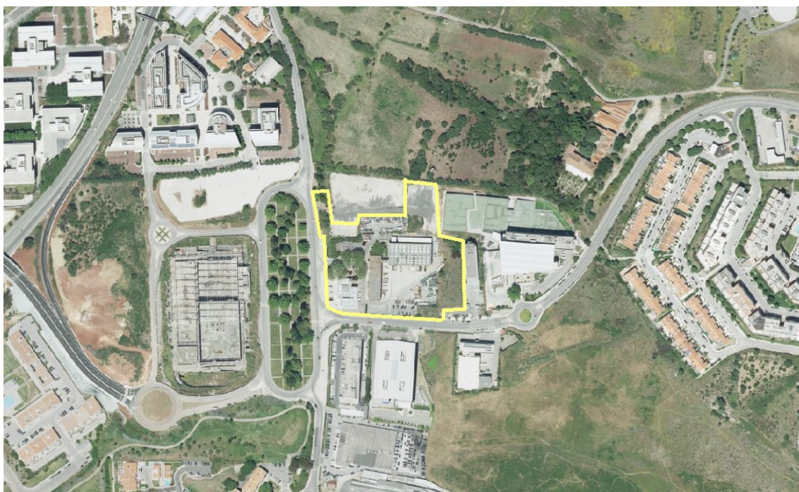
Fig. 1 - Limite indicativo da localização do conjunto de prédios municipais a avaliar (instalações da ex-CNP), localizados em Paço de Arcos . Fonte: GEOPORTAL Oeiras (consultado a 23/01/2023)
