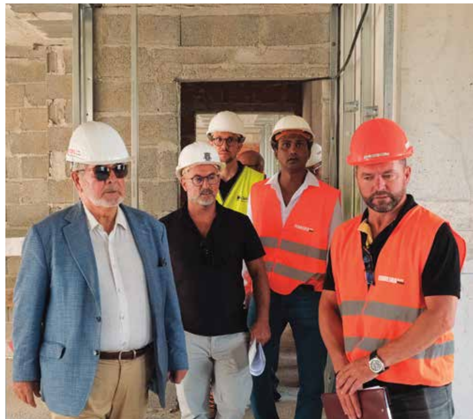
Visita de trabalho ao empreendimento de habitação municipal do Alto da Montanha
