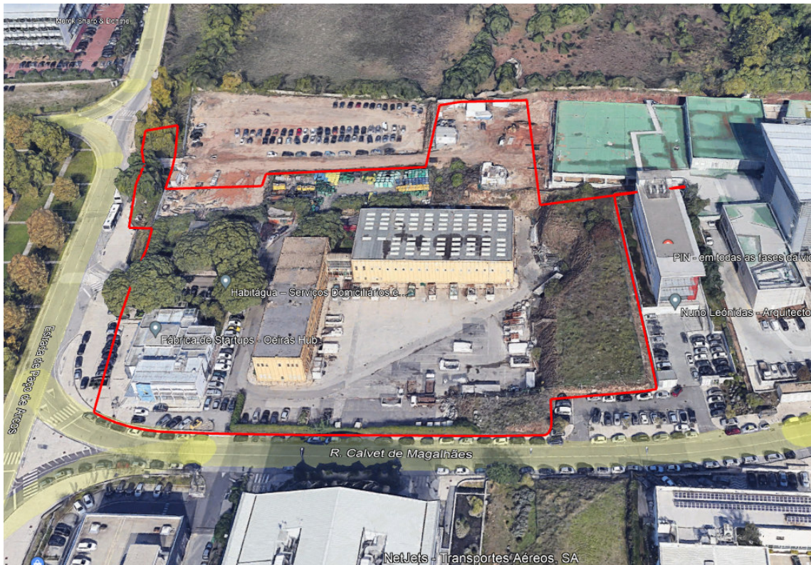
Fig. 1C - Estado atual dos terrenos Municipais (ex-CNP). Fonte: Google Earth, acedido em 08/02/2022.
