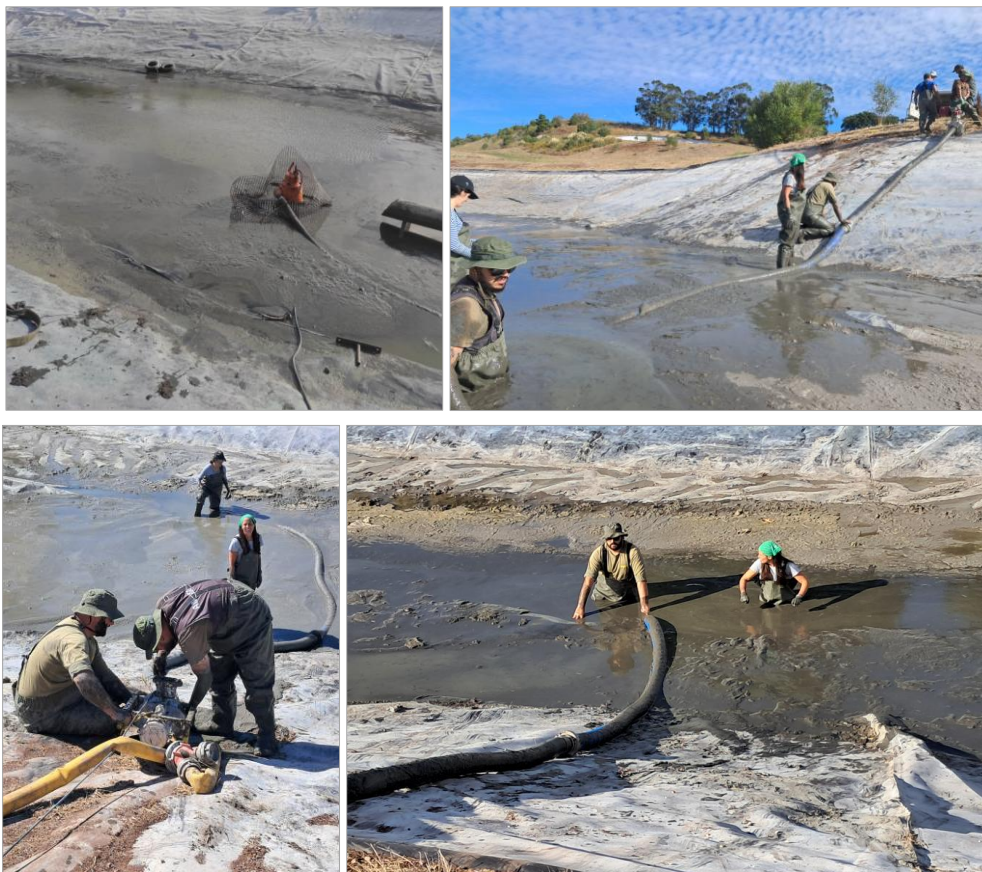
Figura 11. Remoção de sedimentos dos lagos do campo de golfe com apoio de bomba de drenagem
