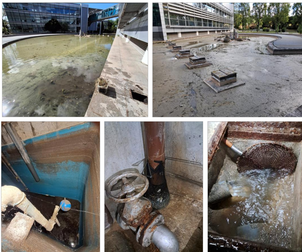
Figura 5. Drenagem dos lagos do parque empresarial
