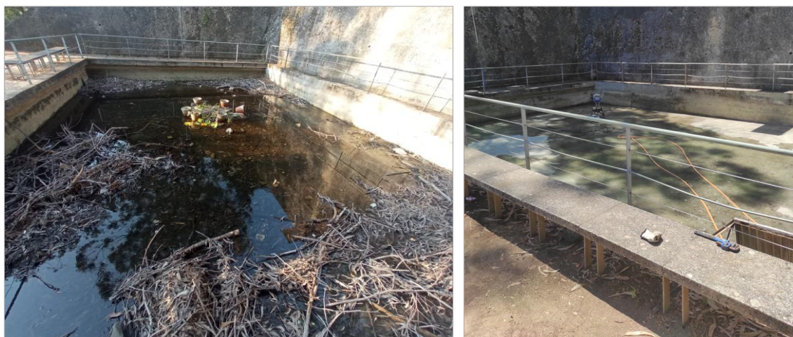
Figura 17. Drenagem e limpeza de tanque do parque municipal
