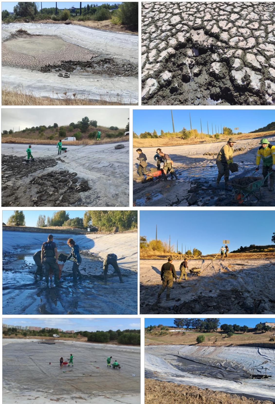
Figura 13. Remoção manual das lamas dos lagos do campo de golfe
