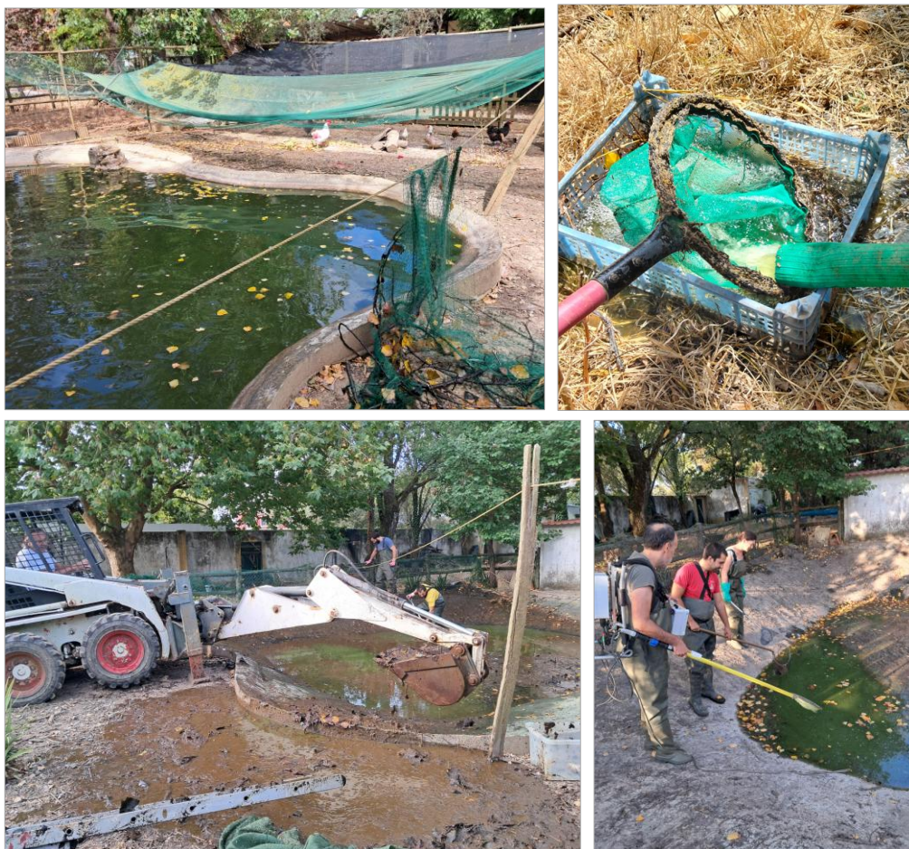
Figura 7. Drenagem e limpeza de tanque privado
