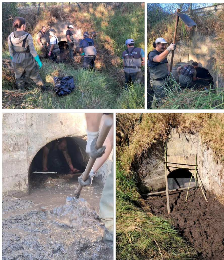
Figura 16. Prospeção, desobstrução e vedação de condutas do campo de golfe
