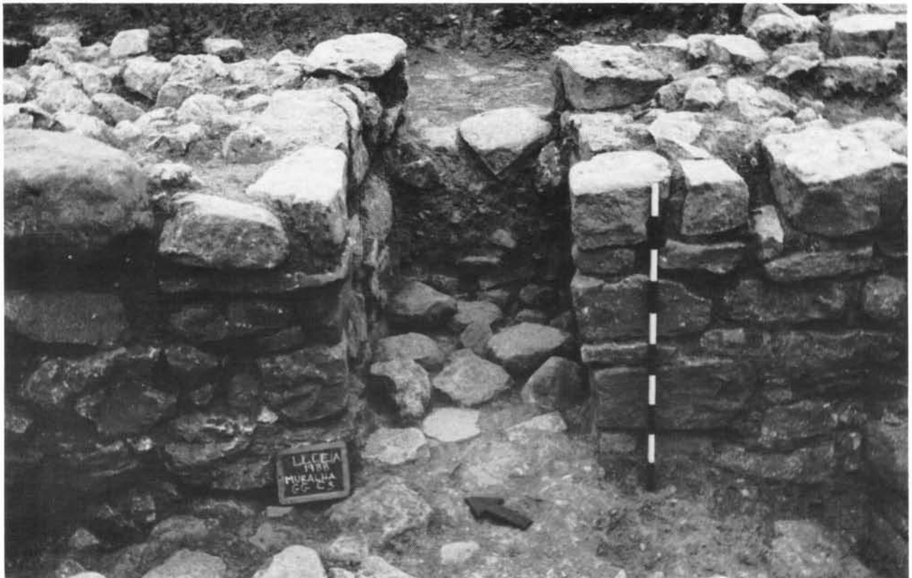
Fig. 55. Vista frontal, do lado externo, da Entrada GGL.
