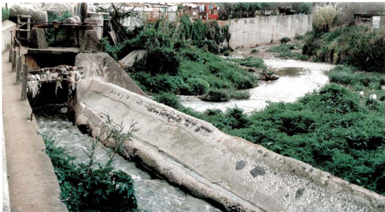
Fot. 13 - Açude de derivação com comporta para o aqueduto de alimentação da Fábrica. Evidencia um alteamento de betão, mais recente.
