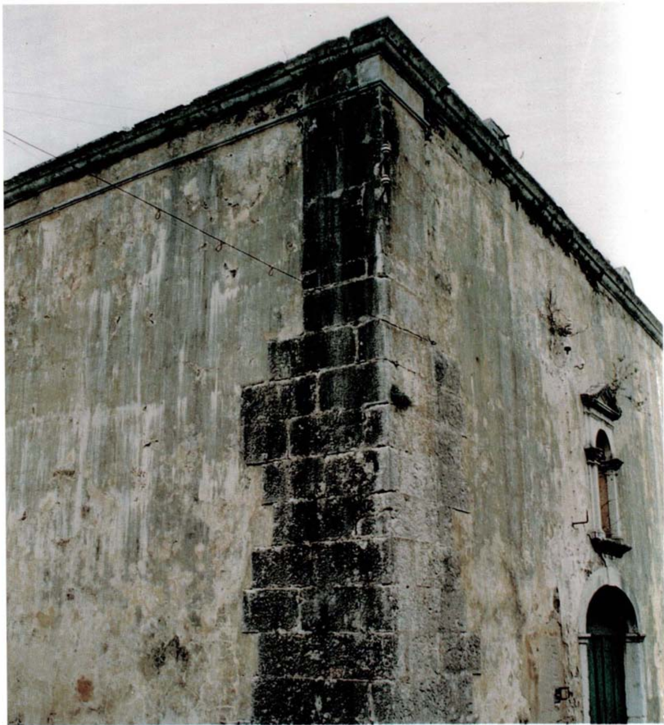
Fot. 6 - Fábrica de Baixo. Cunhal sudeste da fachada principal constituído por blocos de cantaria evidenciando, pelo tamanho e acabamento, duas fases construtivas. A mais recente, representada por blocos de menores dimensões e aparelho mais regular, poder-se-á atribuir à reconstrução subsequente à explosão de 1805.
