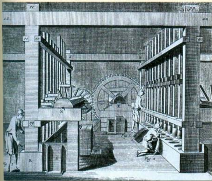
Fig. 11 - Sistema de moagem e encasque da pólvora com pilões, segundo Diderot e D'Alembert, "L'Encyclopédie" (1762-1772).
