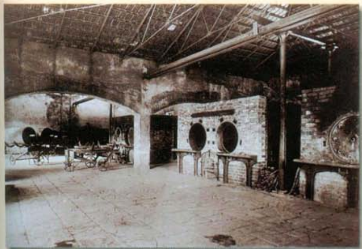
Fig. 28 - Oficina de carbonização (século XIX) da Fábrica da Pólvora de Barcarena, situada na encosta direita da ribeira de Barcarena (reprodução fotográfica de prova antiga em papel, do arquivo CMO/MPN).
