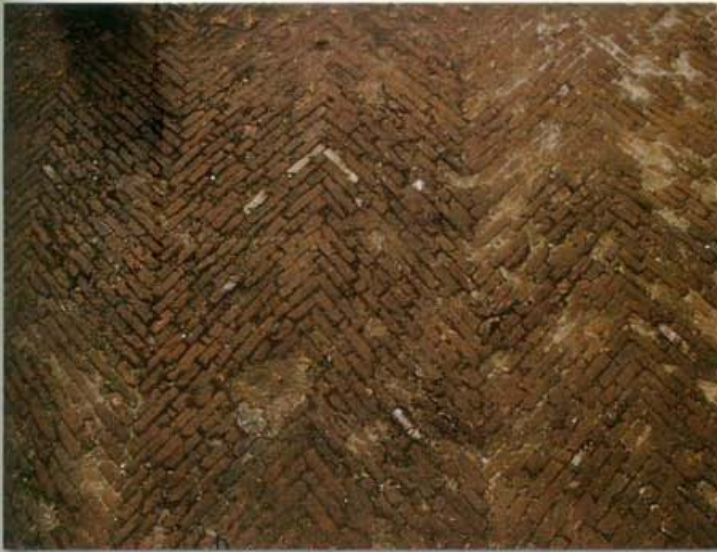
Fig. 18 - Vista parcial do antigo pavimento do “pátio de Santa Bárbara”, fronteiro à Fábrica de António Cremer. Encontra-se forrado de tijoleiras dispostas de cutelo e em espinha, para evitar o risco de faíscas, por atrito.
