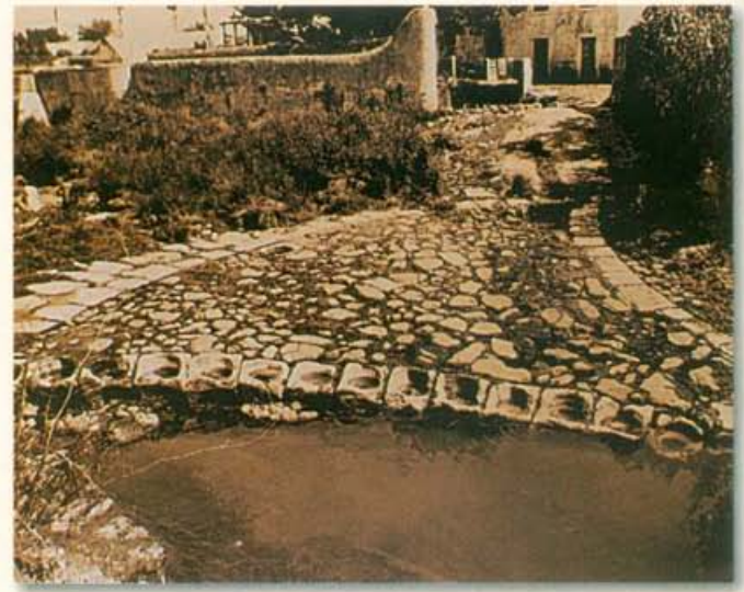
Fig. 12 - Almofarizes da antiga fábrica de pilões de Barcarena, aproveitados para protecção da margem esquerda da ribeira, a montante da Fábrica de Cima (reprodução fotográfica de prova antiga em papel, do arquivo CMO/MPN).
