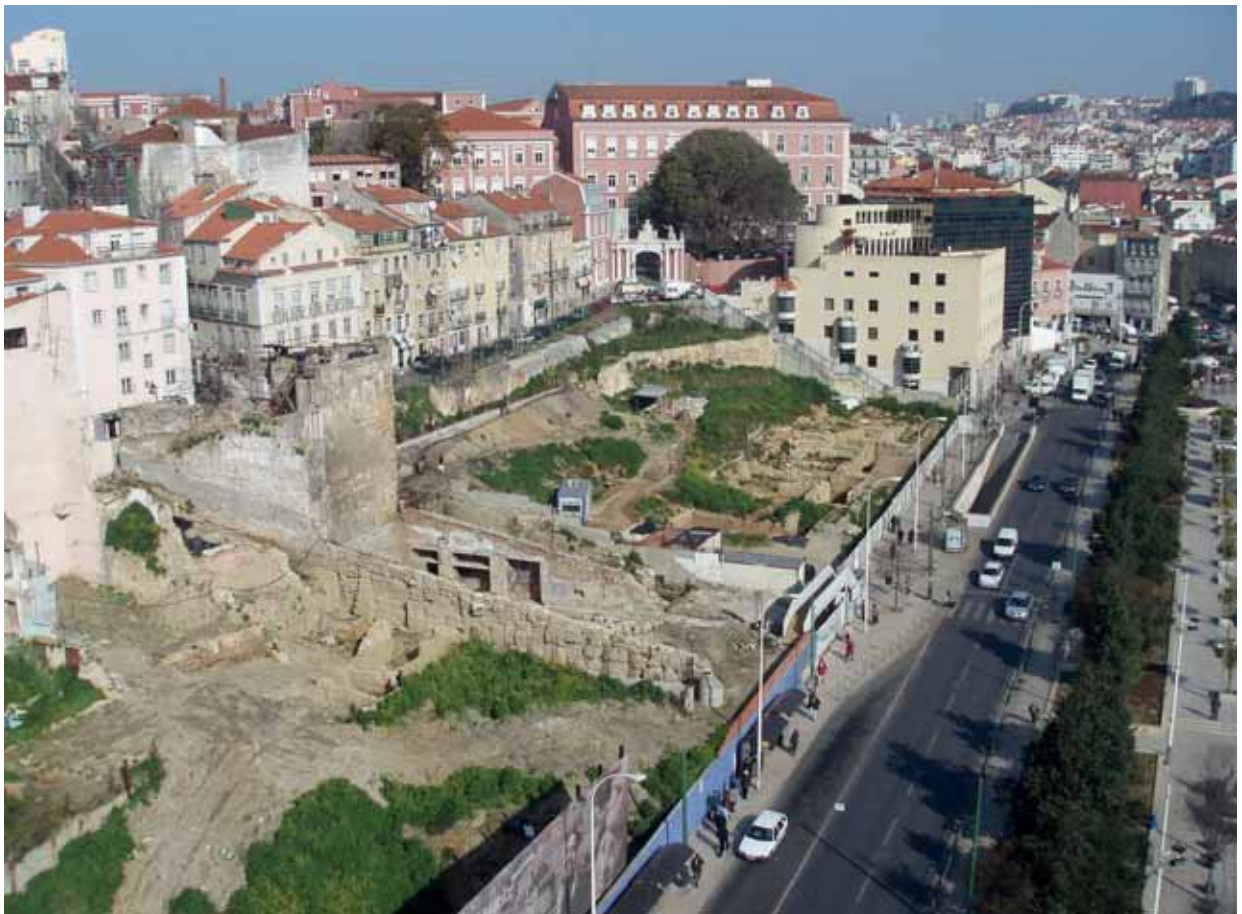
Fig. 3 – Encosta de Sant'Ana. Vista geral de intervenção na Encosta de Sant'Ana.
