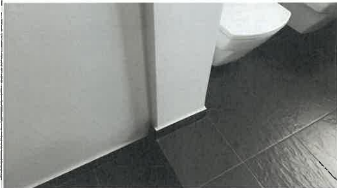
Foto 2 - Instalação sanitária fração 8.º Esq.º
