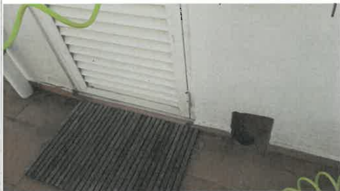
Foto 4 - Ralo de pavimento
