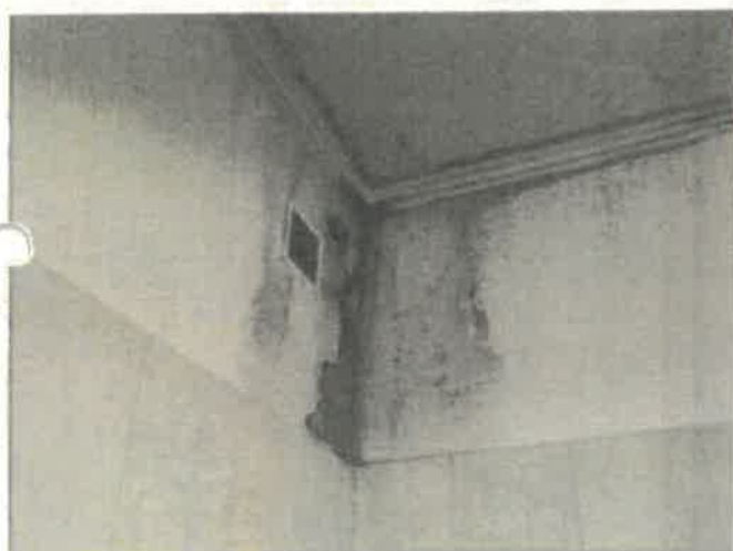
Foto 2 – Tecto e paredes da Instalação sanitária com infiltrações generalizadas
