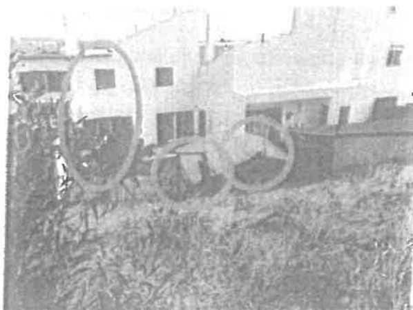
Fig. 26 – Vão de janela 1º piso com aumento de área, vão de porta para lote particular e anexo.
