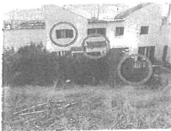
Fig. 25 - Vão de janela 1º piso, aumento de área 1º piso e r/c e vão de porta para lote particular.
