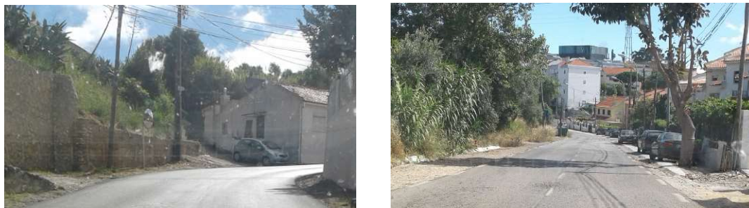
FIGURA 9.31 – EXEMPLOS PAVIMENTOS INADEQUADOS OU EM MAU ESTADO DE CONSERVAÇÃO E AUSÊNCIA DE PASSEIOS/BERMAS
