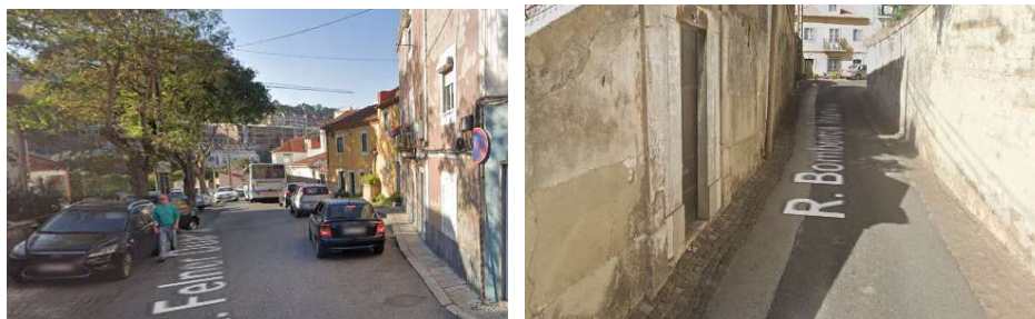
FIGURA 9.18 – EXEMPLOS DE CONSTRANGIMENTOS À CIRCULAÇÃO PEDONAL EM BARCARENA
