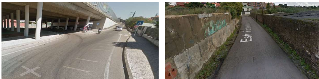
FIGURA 9.20 – VIAS DE ACESSO À ESTAÇÃO DE MASSAMÁ – BARCARENA E ENTRE ENTRE TERCENA E A FÁBRICA DA PÓLVORA DE BARCARENA
