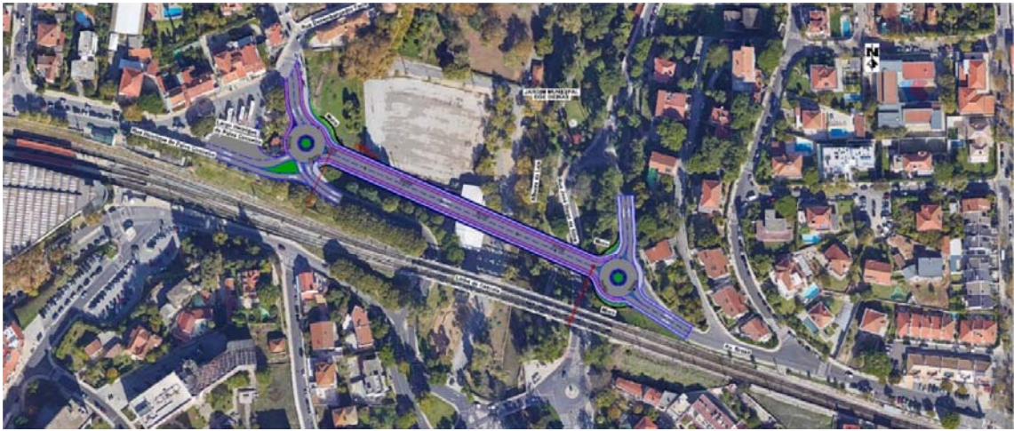
Figura 24 – Viaduto da Variante Sul ao Centro de Oeiras [16]
