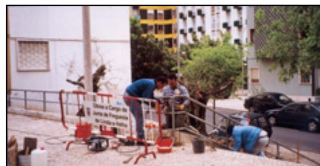
A Junta de freguesia de Linda-a-Velha, no sentido de requalificar os acessos pedonais existentes na sua área de jurisdição, está a colocar guardas metálicas e corrimões nas escadas dos acessos desnivelados, criando, desta forma, melhores condições para quem circula a pé. (informação da Junta de Freguesia)
