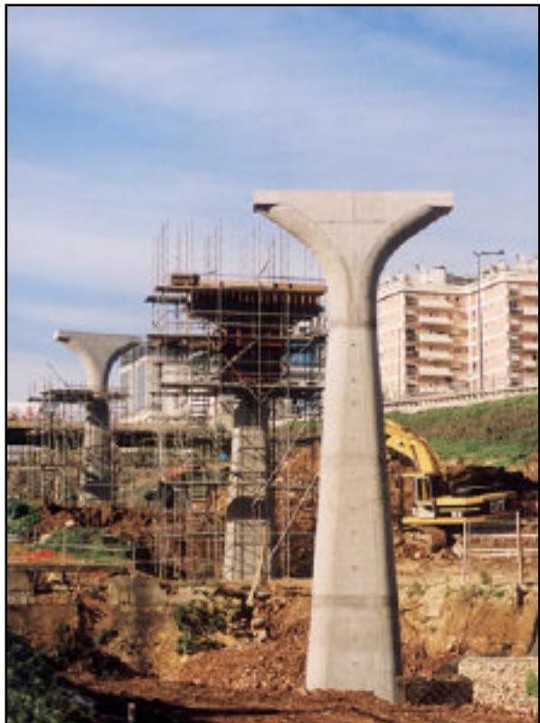
Em ritmo avançado estão as obras de construção do SATU, nomeadamente na zona junto à Estação da CP de Paço de Arcos, e onde se irá localizar a Estação dos Navegantes. Como é perfeitamente visível, já se encontram de pé as estruturas que servirão de pilares ao viaduto por onde circulará o Sistema Automático de Transporte Urbano, e que ligará, numa primeira fase, a Estação dos Navegantes à Estação da Tapada do Mocho, e esta à Estação do Fórum, localizada no Centro Comercial "Oeiras Parque".
