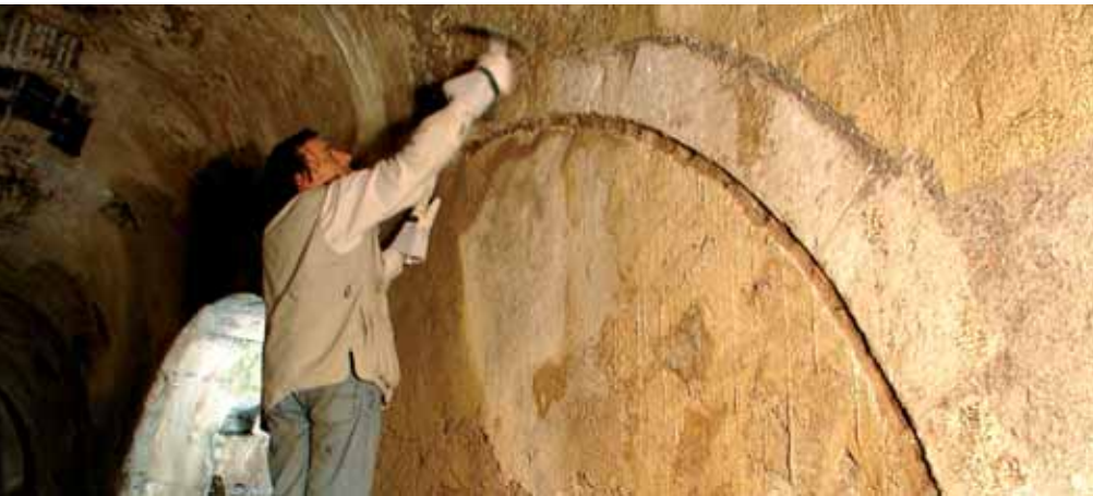
Remoção por picagem das concreções calcárias que cobriam um dos arcos de alvenaria aparelhada originais das ferrarias
