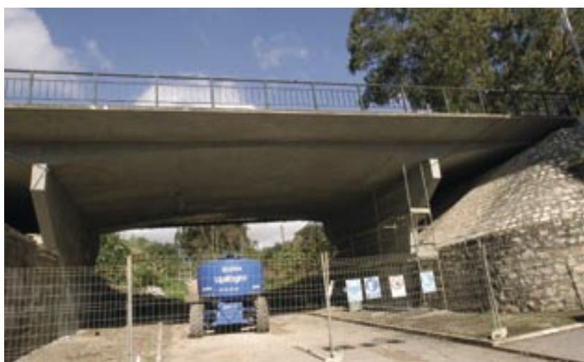
Manutenção da Ponte na Rua Manuel Teixeira Gomes, em Carnaxide – Obra iniciada em Janeiro, adjudicada à empresa Firmino Tuga, SA, no valor de 42 762 €, com prazo de conclusão de 90 dias.
