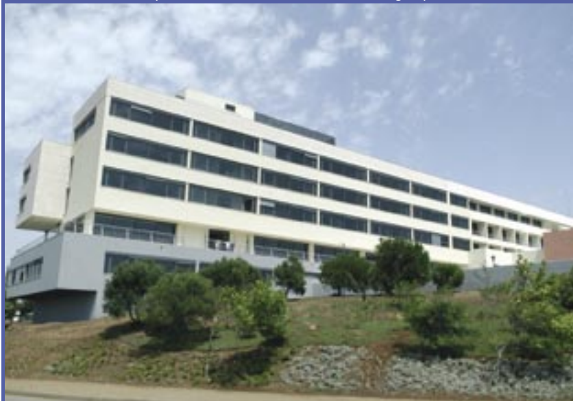
Novo Edifício de Expansão e Núcleo Nentral do Taguspark | Julho
