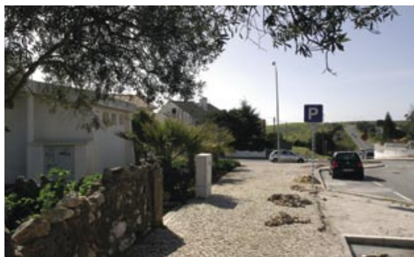
Criação de uma Praça de Táxis no Mercado de Leceia, freguesia de Barcarena – Obra iniciada em Fevereiro, adjudicada à empresa José Ribeiro Alves, Lda., no valor de 13 216 €, com prazo de conclusão de 30 dias.
