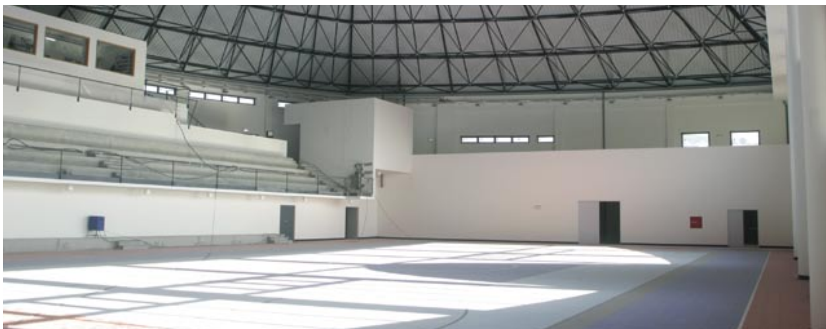
Complexo desportivo da Outurela – Visita de trabalho para acompanhar a evolução das obras relacionadas com o pavilhão multiusos e o campo de jogos ao ar livre.
