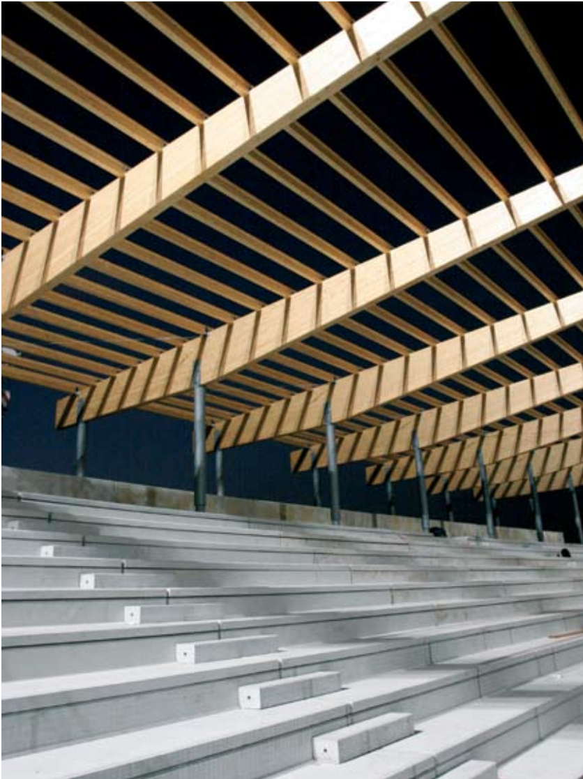
Construção de bancadas no Estádio Municipal de Oeiras
