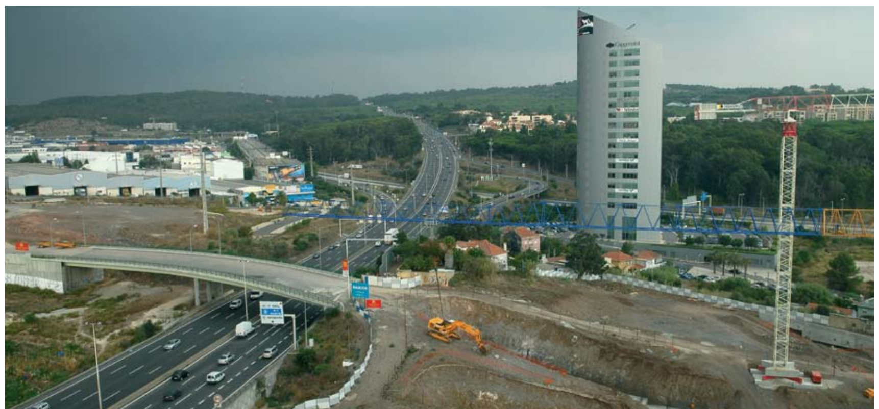
Ligação do viaduto da A5 à rotunda de Miraflores, em obras de finalização
