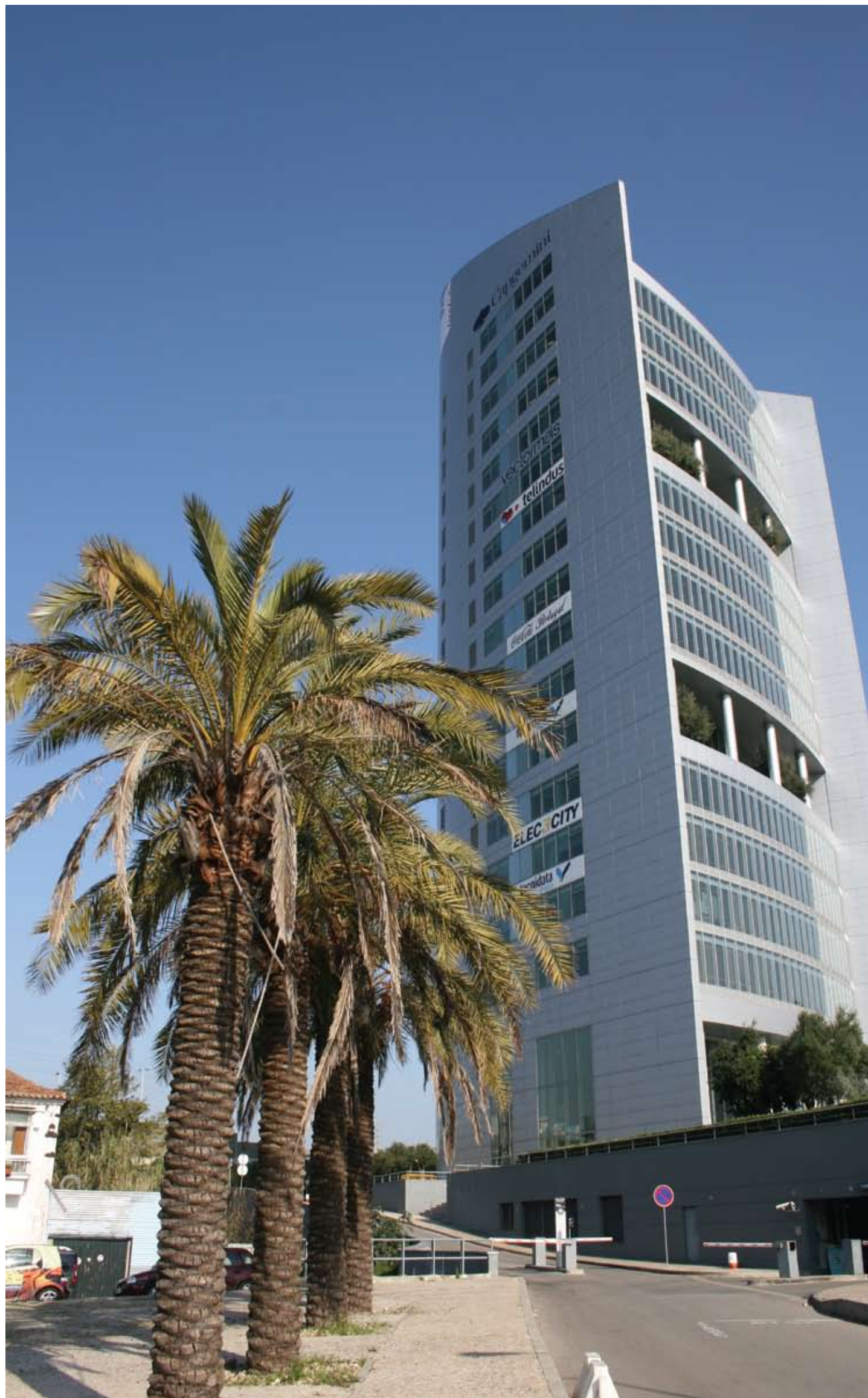
Torre de Monsanto, adjacente ao Arquiparque
