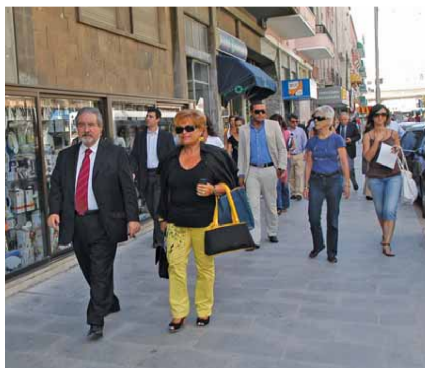
O presidente da Câmara com a presidente da Junta de Freguesia de Algés, Alda Lima, em visita às obras de requalificação dos passeios da Rua Damião de Góis
