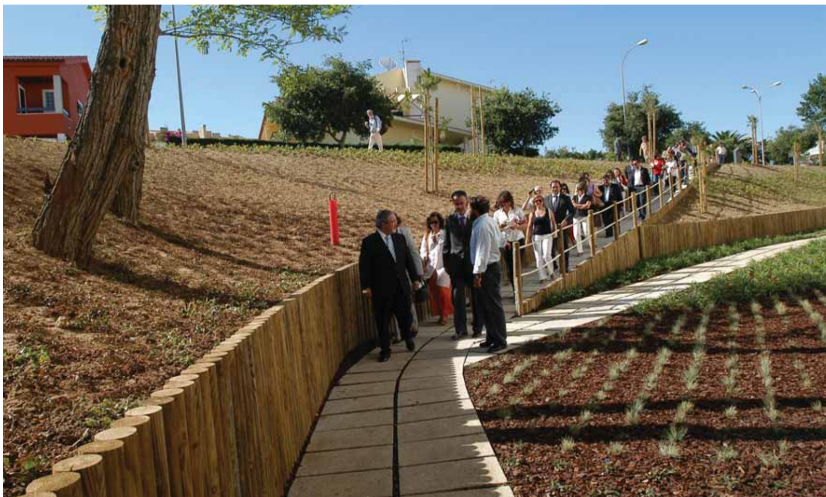
Trabalhos de requalificação e arranjos exteriores no Bairro da Medrosa, freguesia de Oeiras, no valor de 80 mil euros
