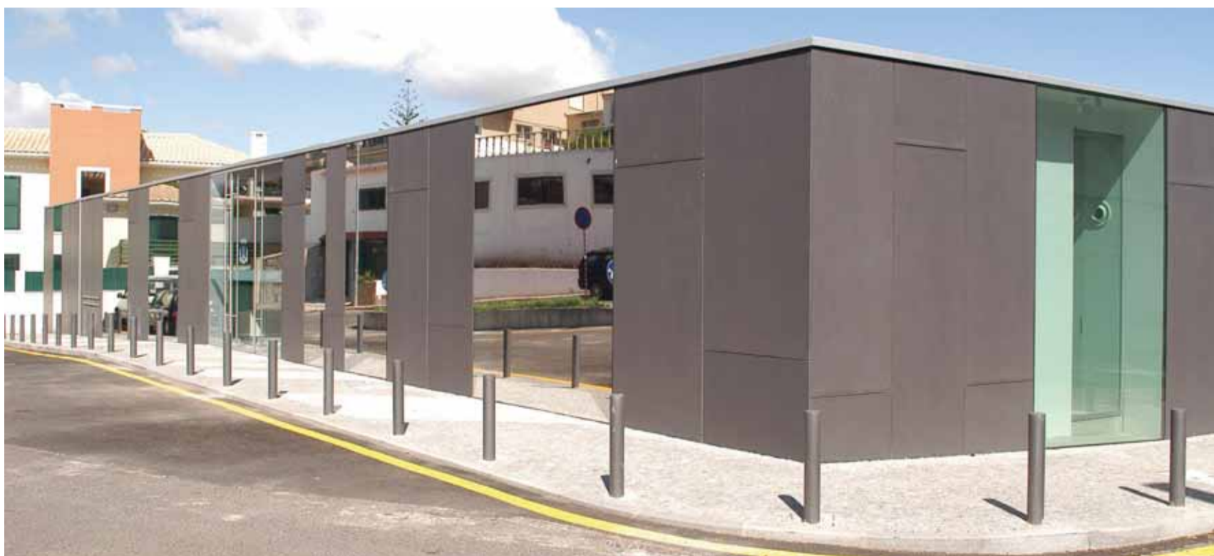
Inauguração do novo edifício sede da Junta de Freguesia de Caxias, obra que representou um investimento global na ordem dos 870 mil euros
