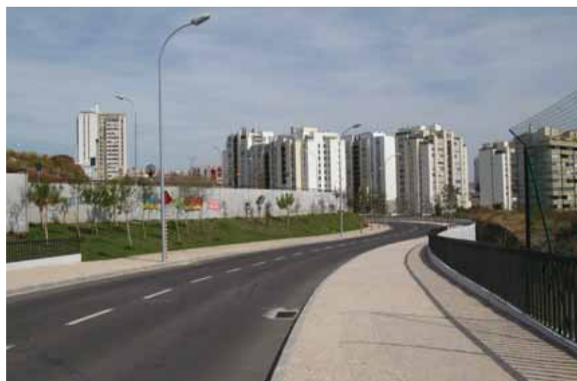
Inauguração do Viaduto do Almarjão - Alameda António Sérgio, Alto de Algés, investimento de 3 milhões de euros
