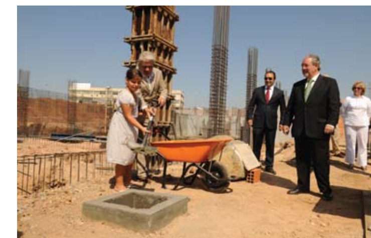
As obras da Escola Básica 1/Jardim-de-Infância de Porto Salvo já começaram.
