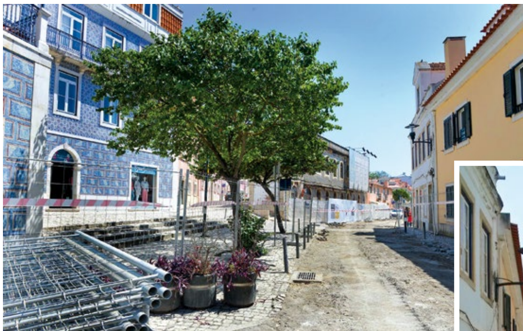
Fotografia durante a obra
