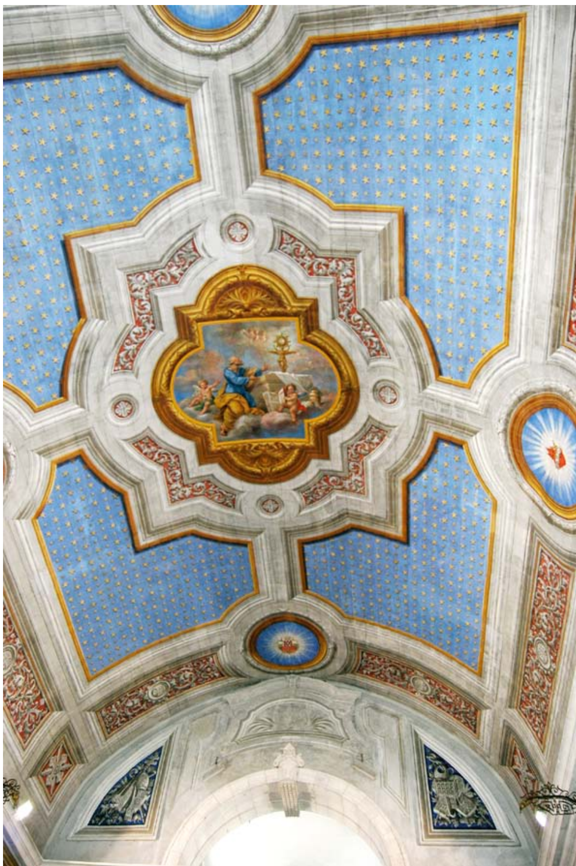
O tecto nave da Igreja de São Pedro, concluídos os trabalhos de recuperação e restauro
