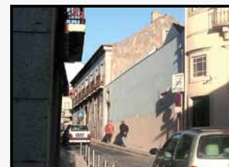
EDIFÍCIO A REABILITAR
