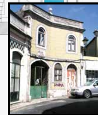
EDIFÍCIO A REABILITAR
