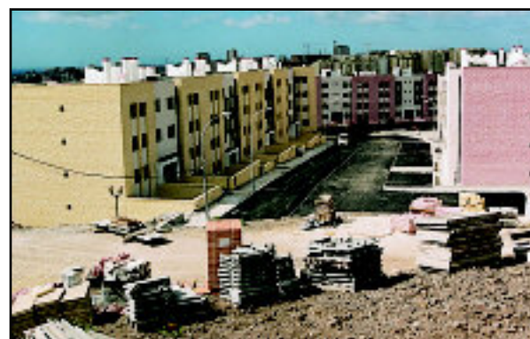
Construção de fogos no Pátio dos Cavaleiros em Carnaxide
