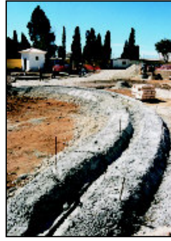
Obras de construção da rotunda junto ao cemitério de Oeiras
