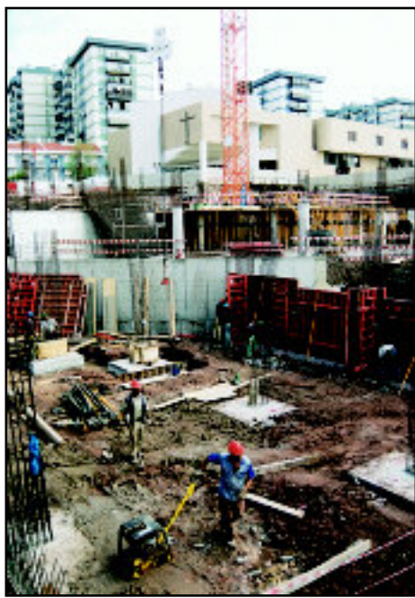
Obras no Centro Cívico de Carnaxide
