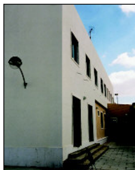
Creche e jardim de infância da Outurela/Portela em trabalhos de finalização
