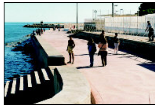
Passeio marítimo - troços A e B entre o INATEL e a praia de Sto. Amaro de Oeiras, já concluídos
