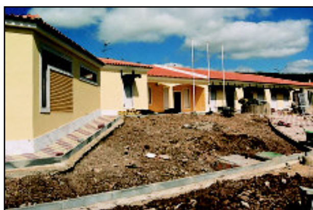
Creche e jardim de infância de Carnaxide, em trabalhos de finalização
