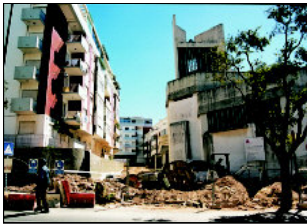
Obras nas canalizações, outras infra-estruturas, piso e passeios na rua Quinta de Coruche em Paço de Arcos
