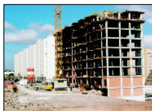
Construção de fogos de habitação municipal no Alto dos Barronhos em Carnaxide
