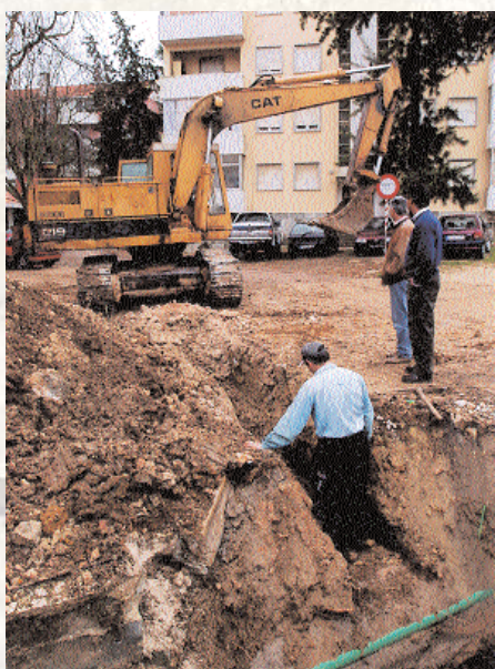
Obras de arranjos exteriores no Bairro da Medrosa, em Oeiras
