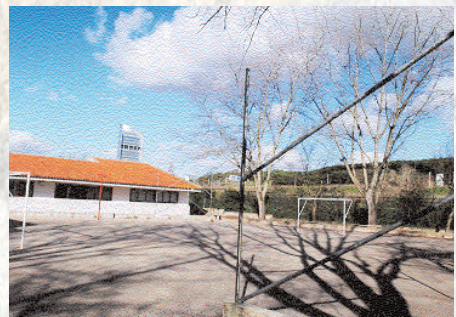
Obras de beneficiação das instalações do Jardim de infância de Algés
