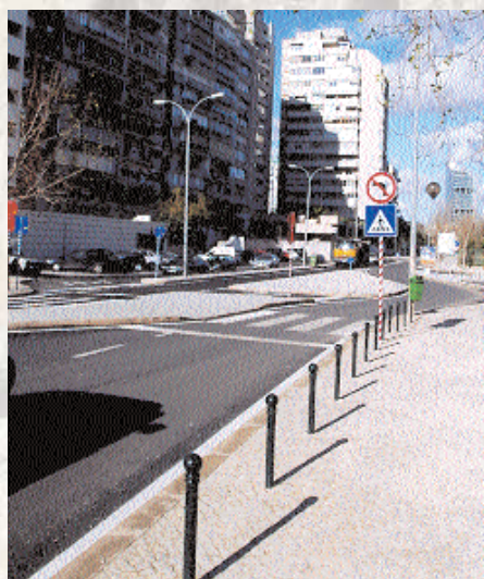
Reperfilagem de troço da Av. General Norton de Matos em Miraflores
