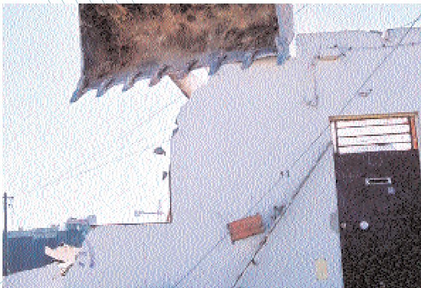
Últimas barracas em demolição
