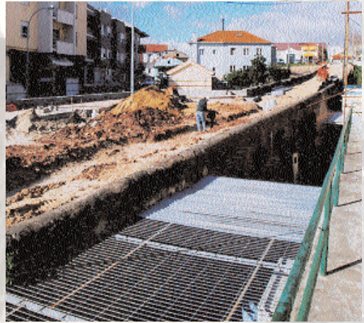
Pavimentação da Rua Conde Rio Maior em Porto Salvo
