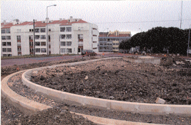
Rotunda em construção junto ao cemitério de Oeiras
