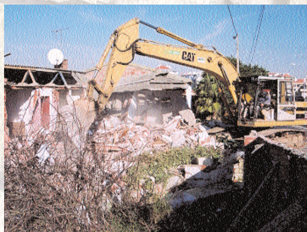
Demolição de barracas no alto de Sta. Catarina, em Cruz Quebrada
