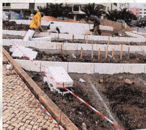
Obras para a colocação da estátua de Camilo Castelo Branco, junto à Escola Secundária de Carnaxide
