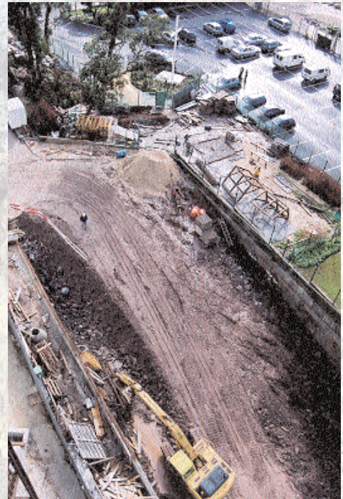
Construção do Parque de estacionamento junto ao Shopping de Miraflores
