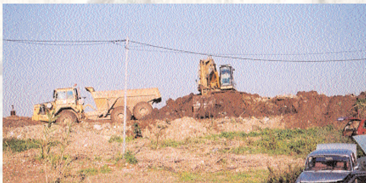
Obras de selagem da lixeira de Vila Fria
