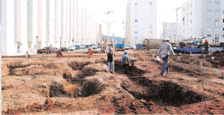
Início da construção do jardim de infância do Alto dos Barrinhos
