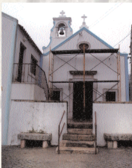
Obras de conservação na Igreja de S. Bento, em Valejas
