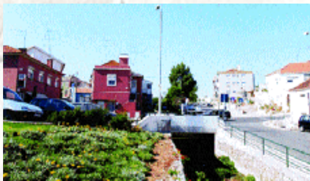
Repavimentação e remodelação da rede de águas da Av. dos Descobrimentos com a rua José Rodrigues Filipe em Porto Salvo
