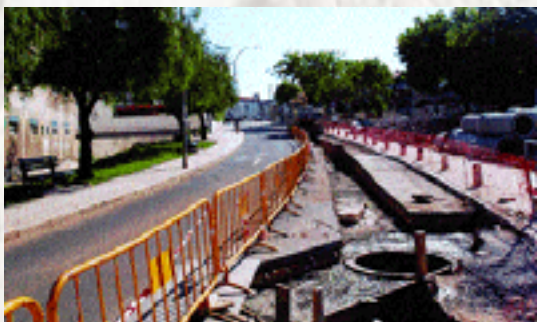
Substituição de canalizações, na Aldeia do Meio em Porto Salvo
