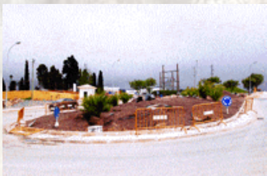
Obras de construção da rotunda do cemitério de Oeiras
