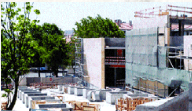
Obras do Centro Cívico em Carnaxide
