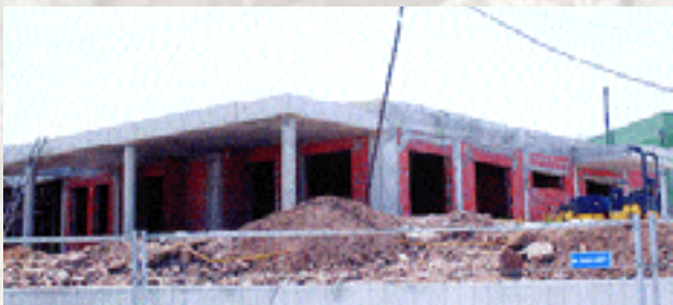
Construção de jardim infância em Alto Barrinhos em Carnaxide
