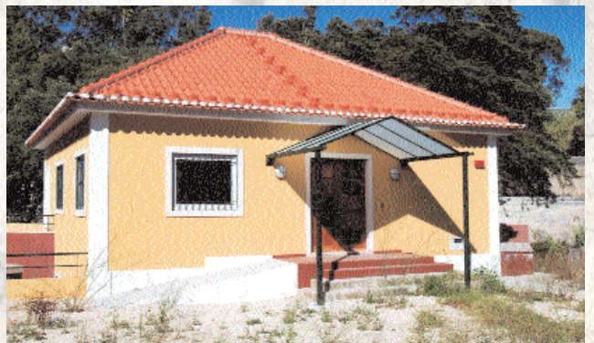
Edifício 14 da Fábrica da Pólvora, recuperado e adaptado - futura Recepção da Fábrica da Pólvora em Barcarena
