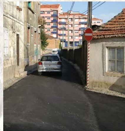
Reparação de arruamentos em Tercena
