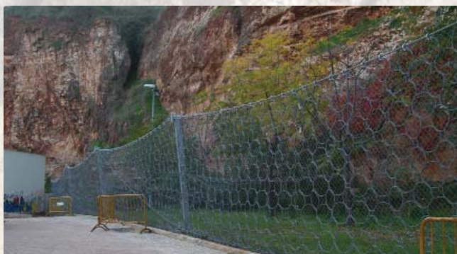
Contenção de escarpa e taludes na Pedreira Italiana
