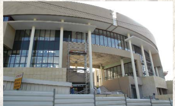
Arranjos exteriores no centro cívico em Carnaxide
