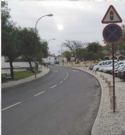
Repavimentação das av. da Descoberta e José Filipe em Porto Salvo
