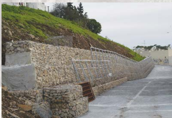
Muro de suporte na rua Dr. Francisco Gentil Martins
