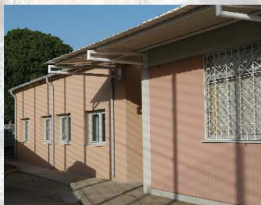
Obras de ampliação da Escola E.B. 1 de Queluz de Baixo
