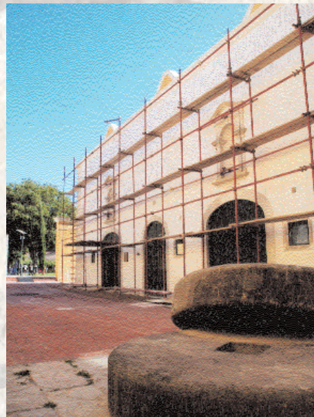
Obras de manutenção da fachada do Museu da Pólvora Negra, Barcarena
