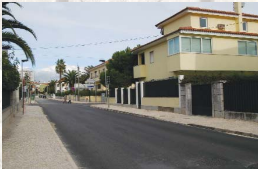
Repavimentação da rua Pedro Álvares Cabral em Linda-a-Velha
