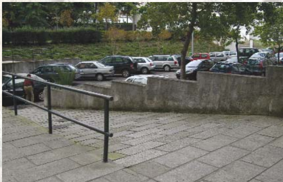
Rampa para deficientes em Miraflores
