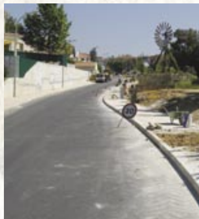
Obras na Avenida Conde Januário, em Paço de Arcos
