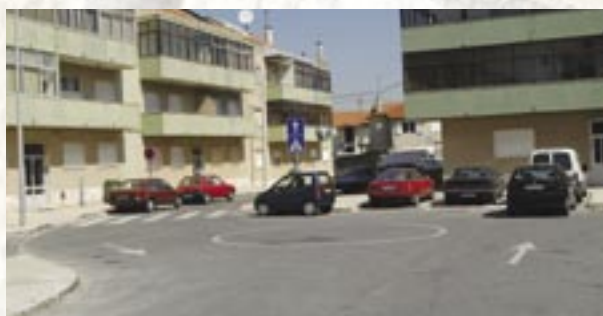
Remodelação da Rua Basílio Telles, em Porto Salvo
