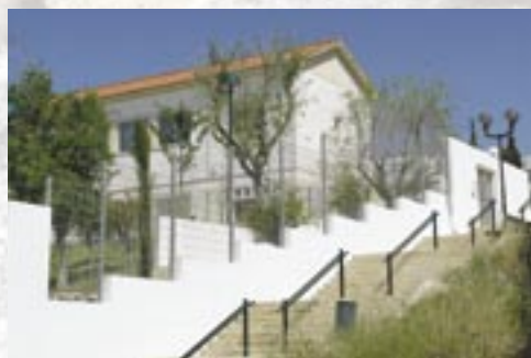
Arranjos exteriores na Escola Básica n.º 1, em Caxias
