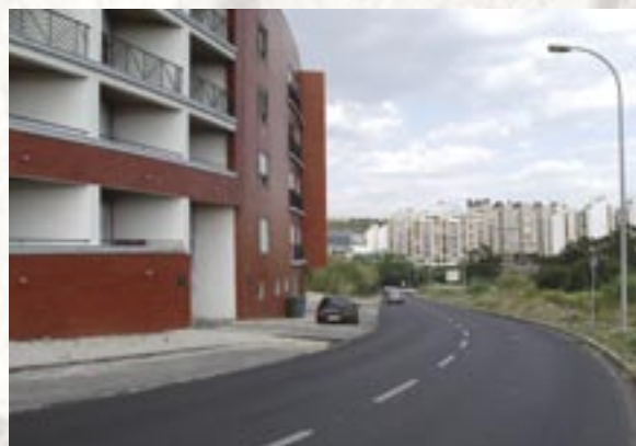
Pavimentação da estrada do desvio em Carnaxide
