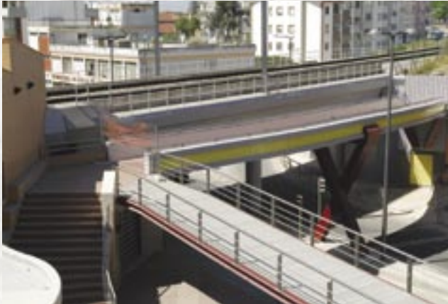
Passadiço pedonal na Avenida Sr. Jesus dos Navegantes, em Paço de Arcos, liga SATU à estação de caminhos de ferro
