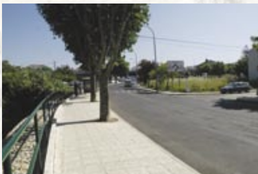
Avenida Infante D. Henrique, em Tercena - repavimentação e arranjo de passeios
