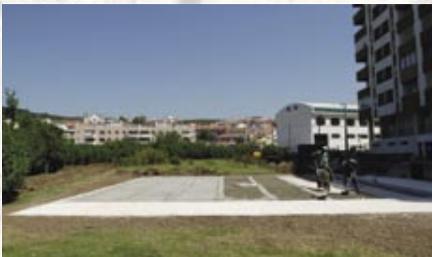
Construção de parque infantil na Rua Amélia Rey Colaço, em Carnaxide
