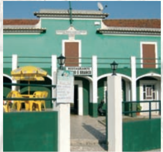
Remodelação das instalações da Sociedade Recreativa da Outurela
