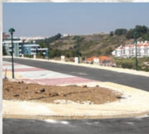
Novos acessos junto à cooperativa de S. Pedro, em Barcarena
