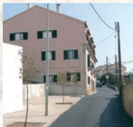
Colocação de novo asfalto na Rua Elias Garcia, em Barcarena
