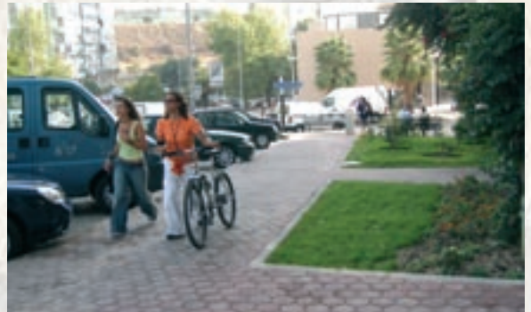
Arranjos Exteriores envolventes à Rua Manuel Teixeira Gomes, em Carnaxide
