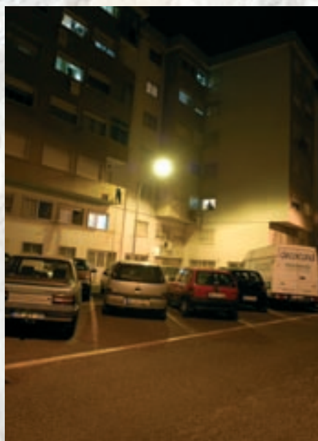
Remodelação da iluminação pública no Largo Costa Lobo, em Linda-a-Velha
