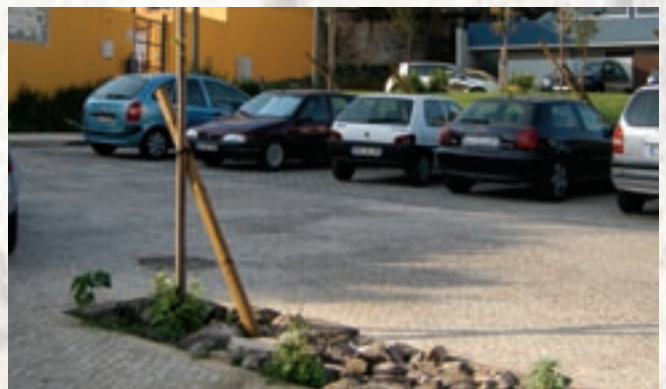
Asfaltagem dos acessos e estacionamento na quinta do Sales - Outurela
