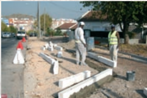
Requalificação do Arranjos Exteriores no Bairro 18 de Maio, em Carnaxide
