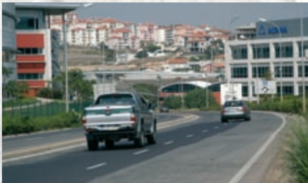
Aplicação de pavimento anti-derrapante tipo "safegrip" num troço da Av. Conselho da Europa, em Oeiras
