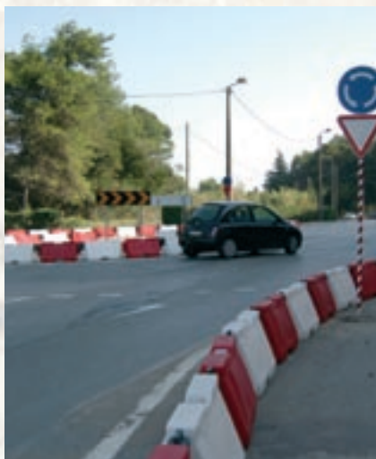
Reordenamento viário na Cruz-Quebrada
