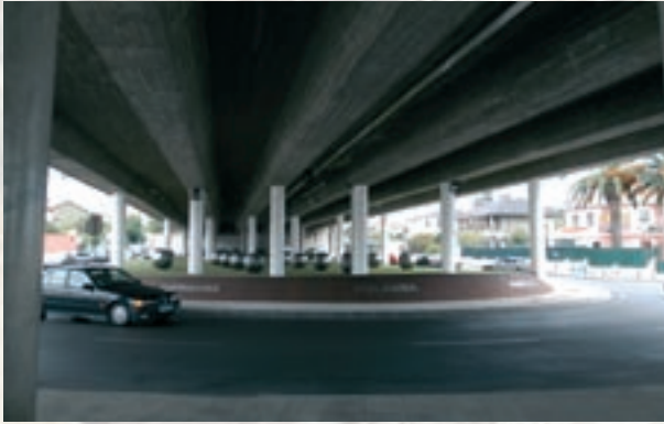
Execução de obras de drenagem na Rotunda das Selecções em Tercena
