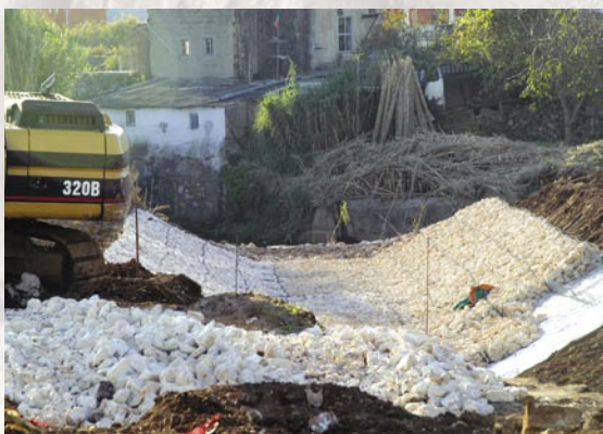
Regularização da ribeira de Queijas, no troço junto ao bairro Francisco Sá Carneiro em Caxias
