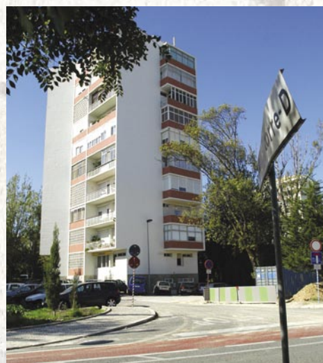
Arranjo dos acessos à praqueta da Torre D na Alameda Conde de Oeiras
