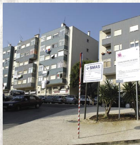
Obras de revalorização no âmbito do PROQUAL em Algés
