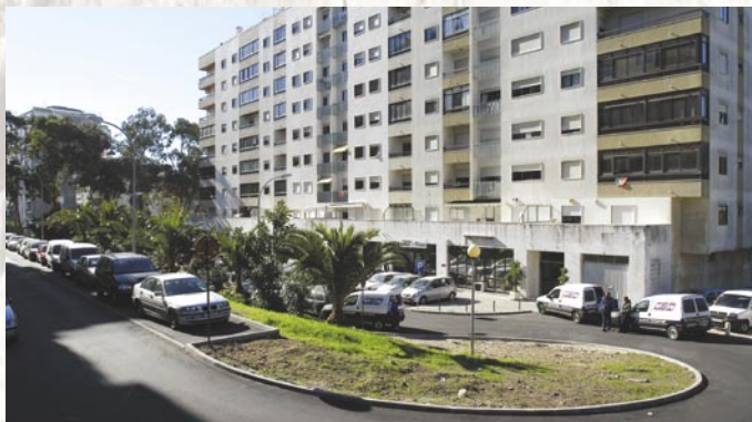
Novo arruamento de ligação à rua de Nora em Carnaxide
