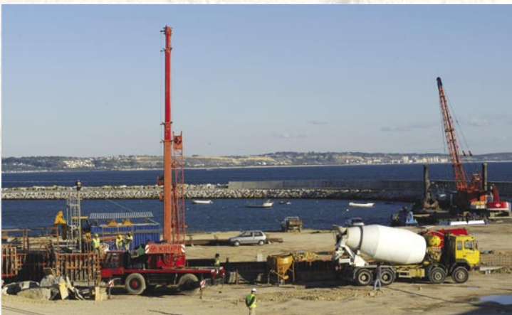
Início das obras do Porto Recreio de Oeiras
