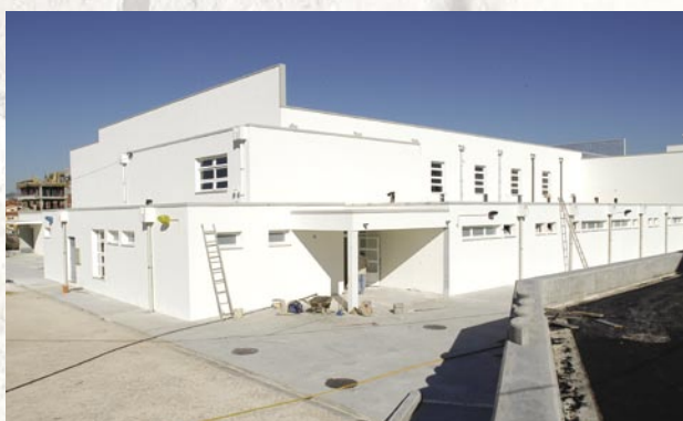
Novo pavilhão desportivo Noronha Feio em Queijas
