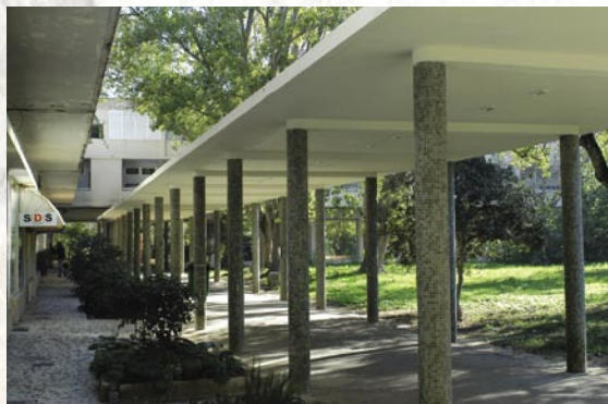
Obras na cobertura da passagem pedonal no átrio comercial de Nova Oeiras
