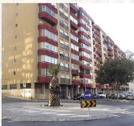
Remodelação viária na rua General Ferreira Martins em Algés
