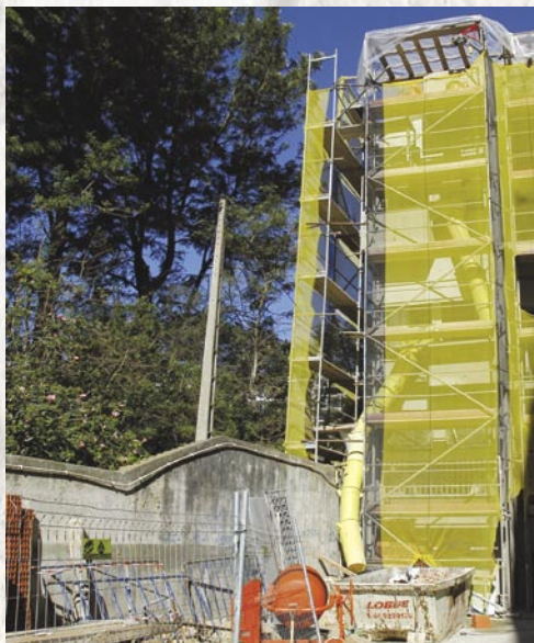
Obras de adaptação do antigo quartel dos Bombeiros Voluntários do Dafundo, para ali funcionar a extensão do Centro de Saúde
