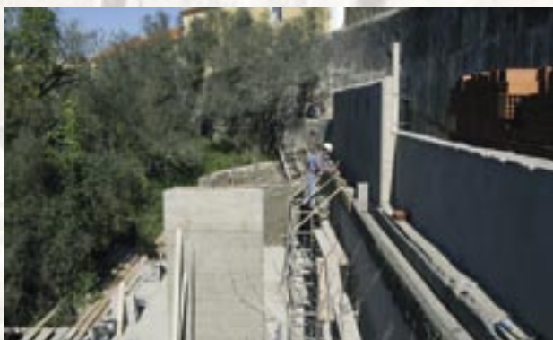
Recuperação de edifícios na Fábrica da Pólvora de Barcarena
