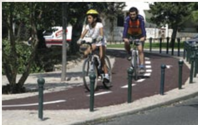
Novo troço da ciclovia em Nova Oeiras
