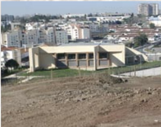
Obras na zona desportiva da Outurela/Portela
