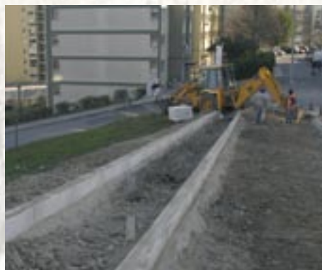
Rua Marcela Pires Messias na Terugem, em Caxias - obras de asfaltagem e arranjo envolvente
