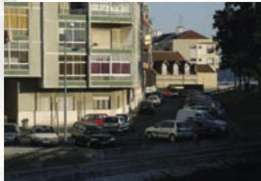
Arranjos exteriores na rua Conselheiro Dias e Sousa no Dafundo
