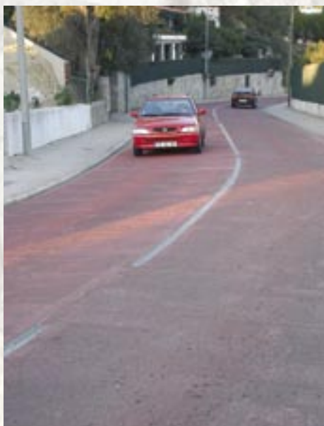
Piso Safegrip (anti-derrapante) na Av. Salvador Allende em Caxias
