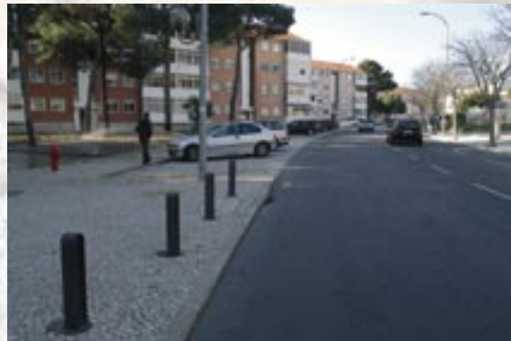
Repavimentação e arranjos circundantes na rua D. João I na Medrosa, Oeiras
