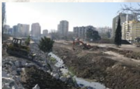
Obras do Parque Urbano de Mirafleres
