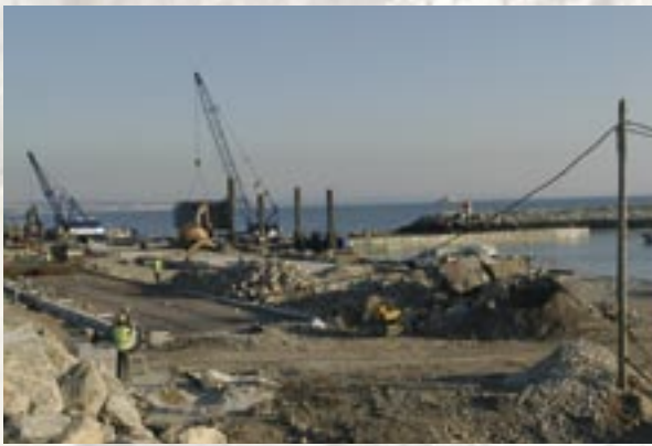
Obras de construção do Porto de Recreio em Oeiras (ver pág. 34)
