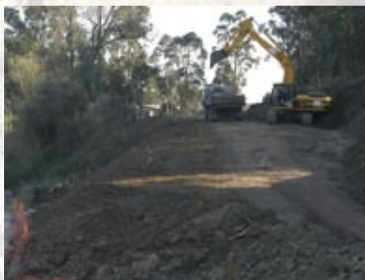
Rectificação do traçado do arruamento junto ao edifício 51 Fábrica da Polvora de Barcarena
