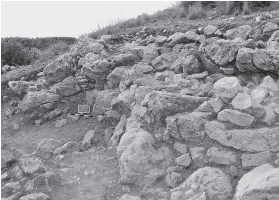
Fig. 16 – Outeiro Redondo. Duas vistas do sector oriental do dispositivo defensivo, correspondente à muralha mais antiga (Muralha G). Observe-se a existência de sucessivos panos de alvenaria adossados longitudinalmente, por forma a assegurar a estabilidade da plataforma assim criada, pelo seu peso próprio.
